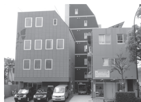
「グリーンホール環七野方」外観(左側の建物)
